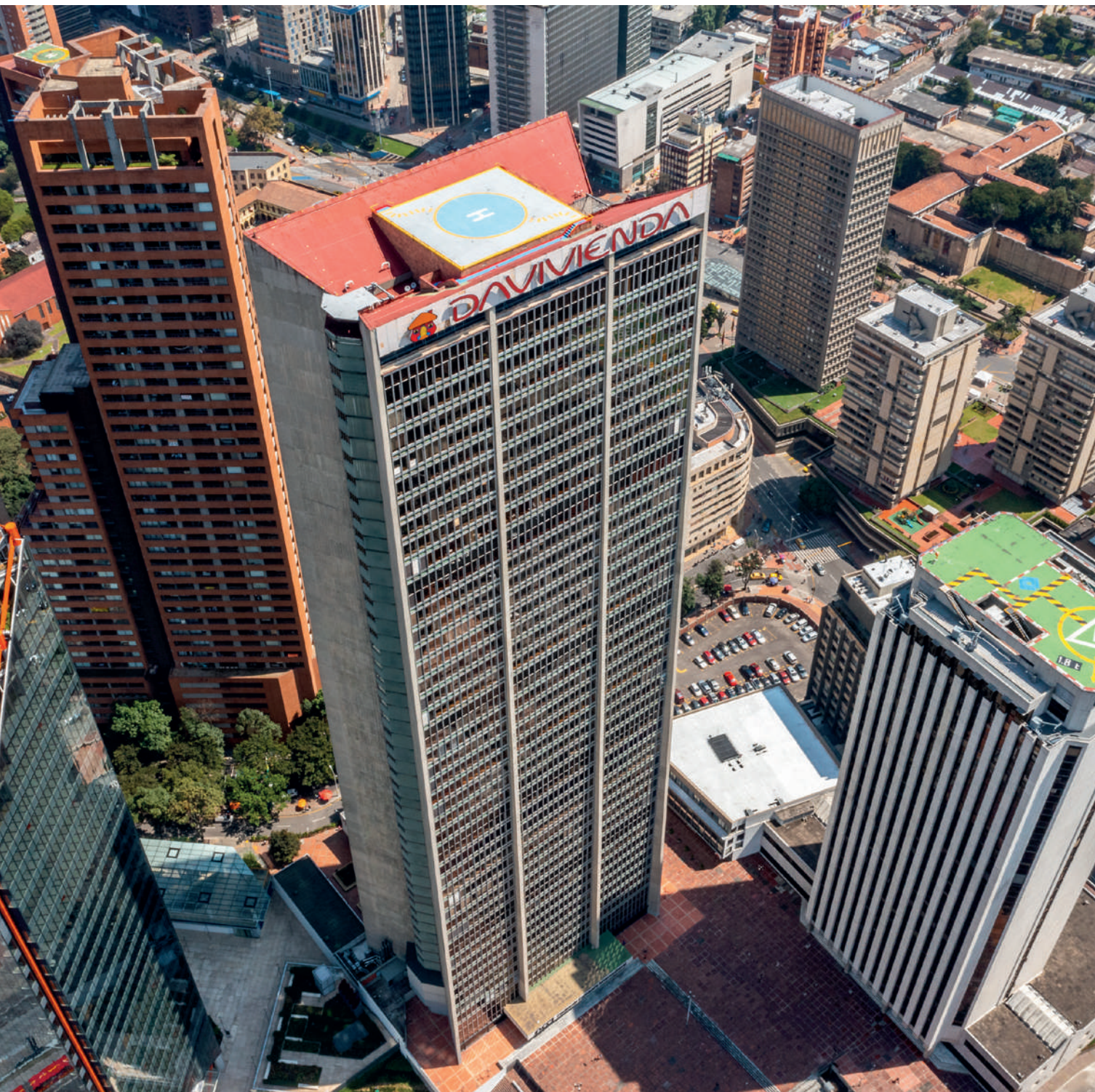
DAVIVIENDA TORRE CCI -Bogotá
